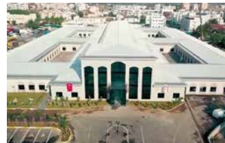
Станция скорой помощи в Никосии, Кипр
