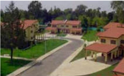
İncirlik Binası, Adana
